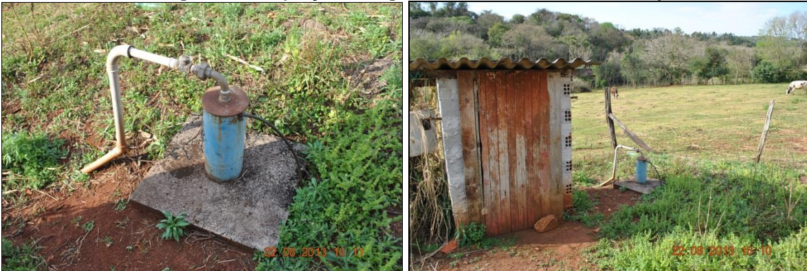
Figura 28 - Captação de Água da Comunidade Linha Ocoy.
