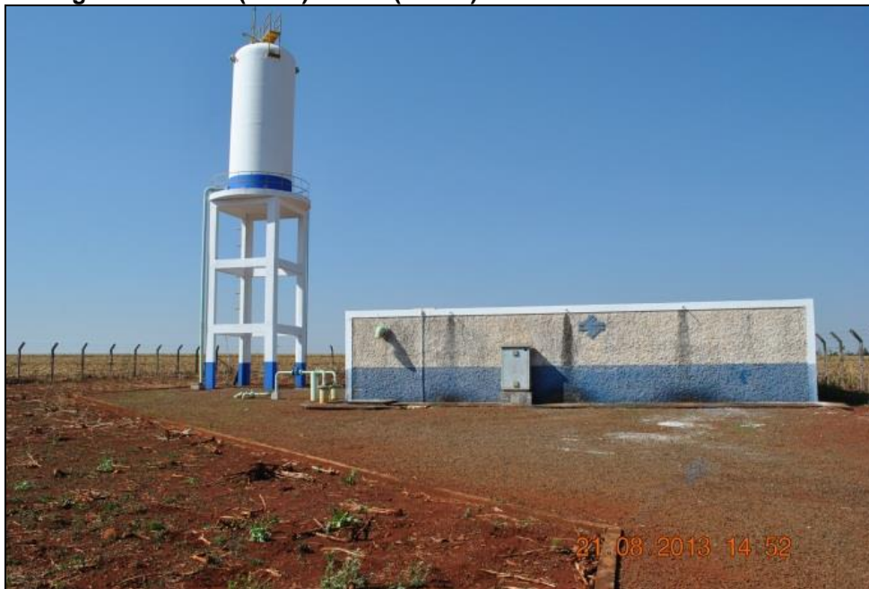
Figura 44 – REL (50m 3 ) e RAP (500m 3 ) localizados na Área Industrial.
