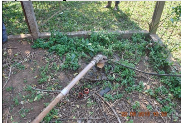
Figura 31 - Captação de Água do Distrito de Maralúcia - Sistema 01.
