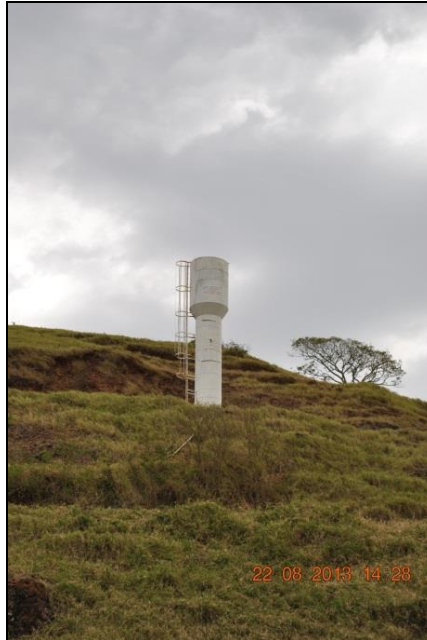
Figura 47 - Reservatório Elevado da Comunidade Linha Mineira.
