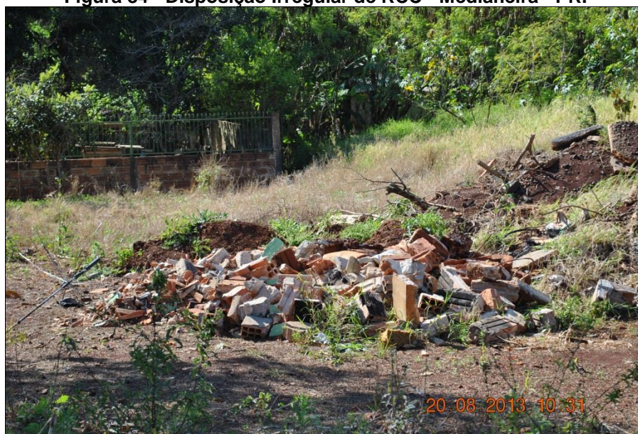
Figura 84 - Disposição Irregular de RCC - Medianeira - PR.
