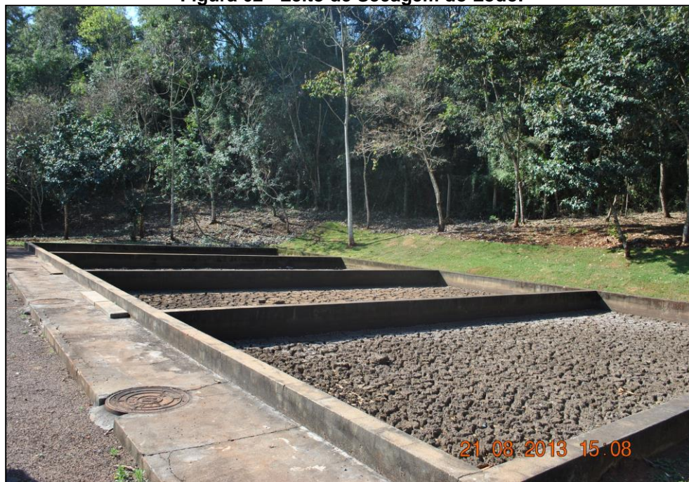
Figura 62 - Leito de Secagem do Lodo.
