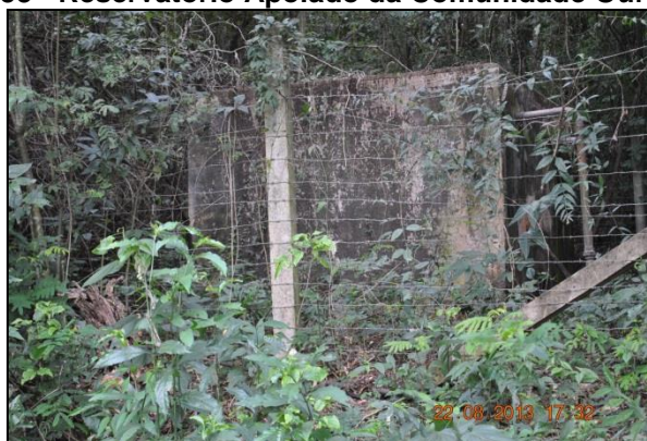
Figura 53 - Reservatório Apoiado da Comunidade Ouro Verde.
