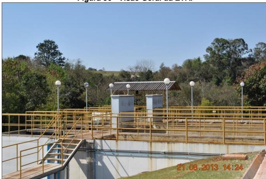
Figura 36 - Visão Geral da ETA.
