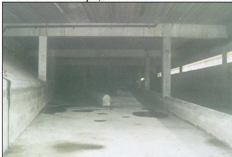
Figura 1123 – Bacia de detenção, estrutura de armazenamento subterrânea.
