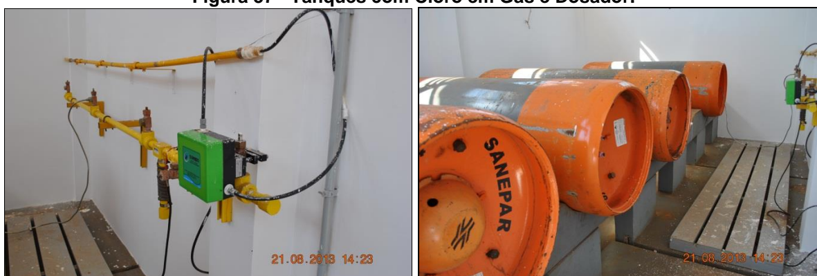
Figura 37 - Tanques com Cloro em Gás e Dosador.
