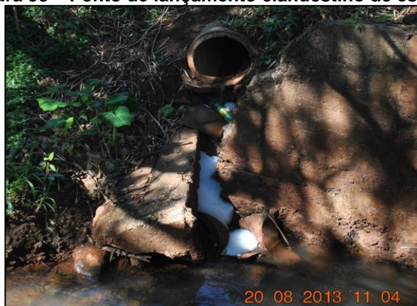
Figura 58 – Ponto de lançamento clandestino de esgoto.
