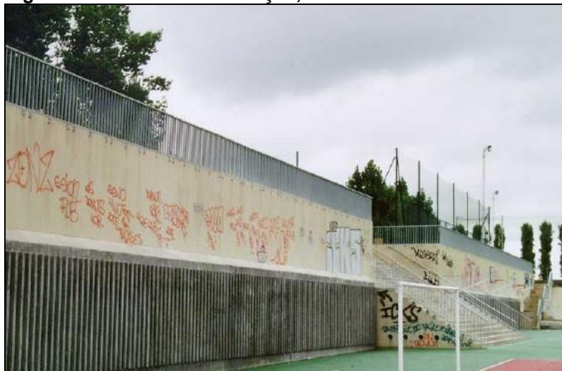
Figura 1122 – Bacia de detenção, estrutura de armazenamento.
