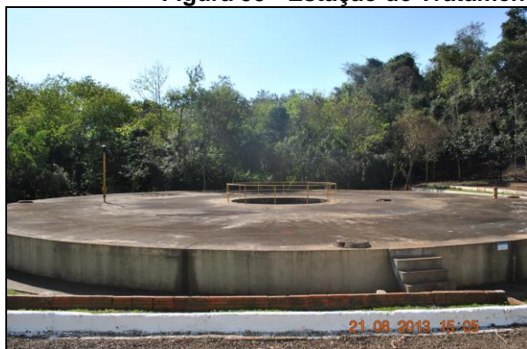
Figura 55 - Estação de Tratamento dos Esgotos - Reator Anaeróbio.
