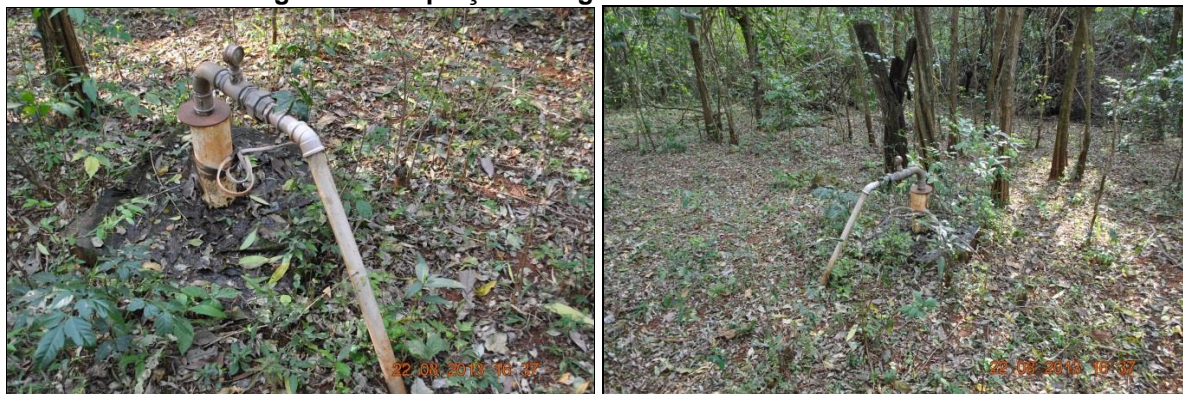
Figura 34 - Captação de Água da Comunidade Rio Javali.
