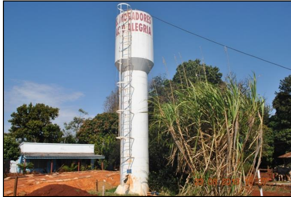
Figura 46 - Reservatório Elevado da Comunidade Alto Alegria.
