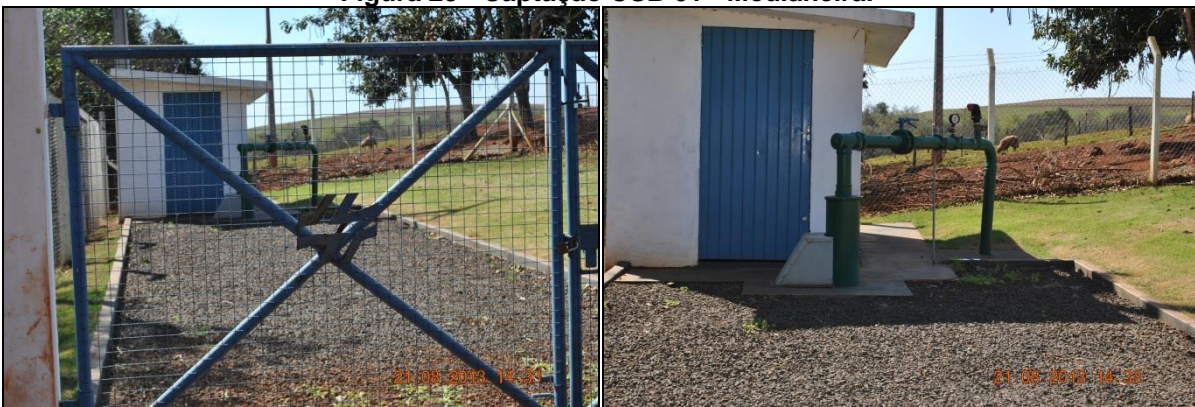
Figura 23 - Captação CSB 01 - Medianeira.
