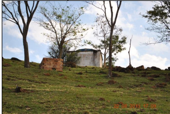
Figura 50 - Reservatório Apoiado da Comunidade Linha Vitória.
