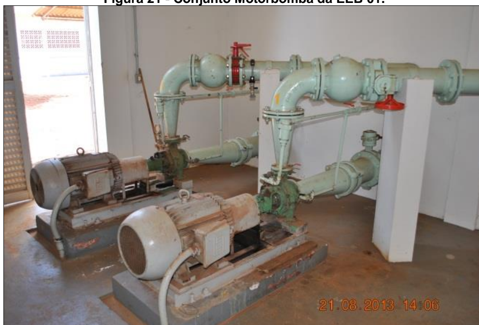
Figura 21 - Conjunto Motorbomba da EEB 01.
