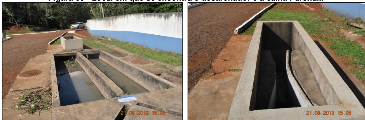
Figura 60 - Local em que se encontra o desarenador e a calha Parshall.
