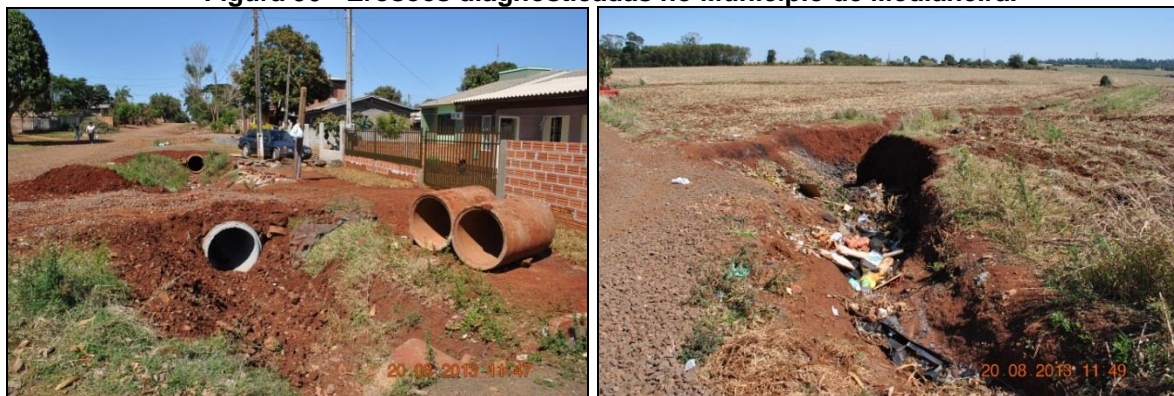
Figura 90 - Erosões diagnosticadas no Município de Medianeira.
