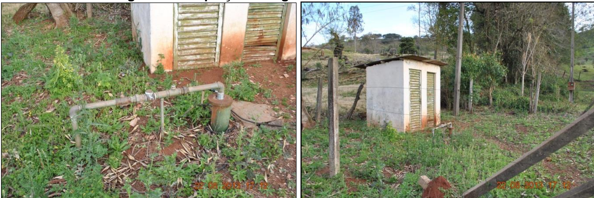
Figura 30 - Captação de Água da Comunidade Linha Vitória.
