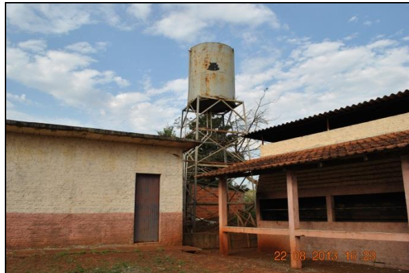
Figura 48 - Reservatório Elevado da Comunidade Linha Ocoy.
