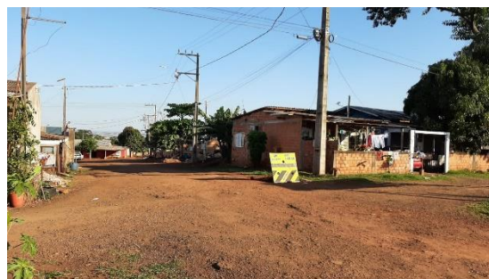
B. Ruas do bairro Bom Jesus, sem pavimentação.
