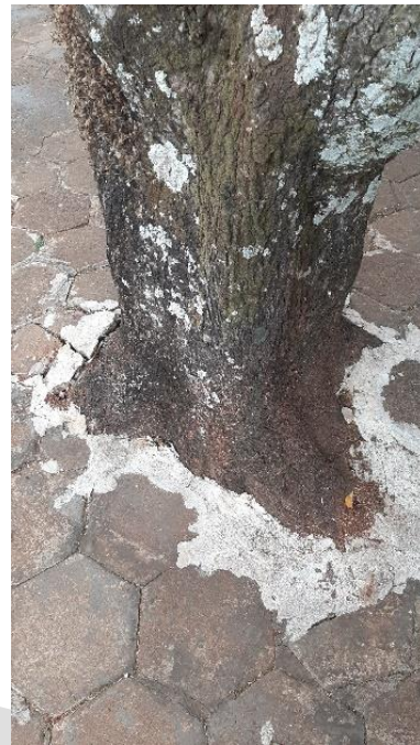
F. Exemplo de ausência de canteiro, com concreto até o colo da árvore.
