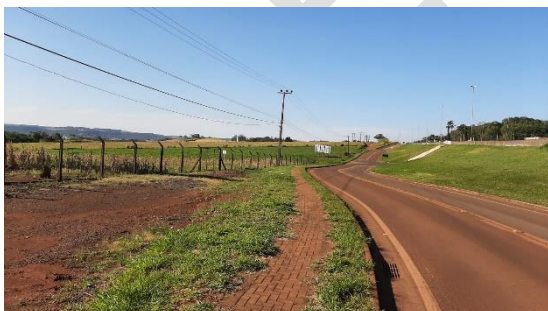
I. Rodovia BR-277 no bairro São Braz.
