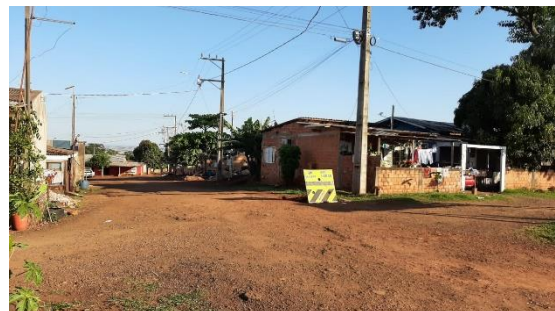
B. Ruas do bairro Bom Jesus, sem pavimentação.
