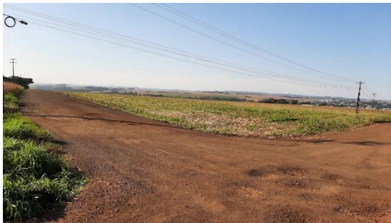
C. Ruas do bairro Chácara Paraíso, sem pavimentação.
