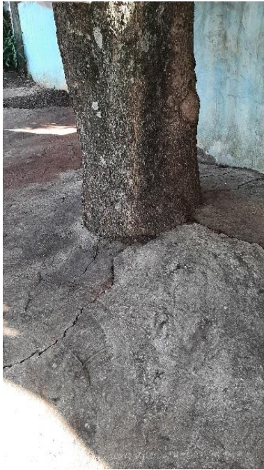
E. Exemplo de ausência de canteiro, com concreto até o colo da árvore.
